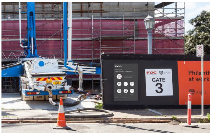
Site signage example
